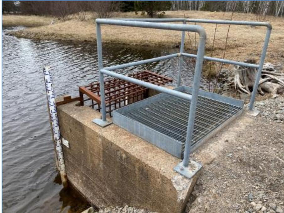
**Figure 18-58: Discharge Weir**
